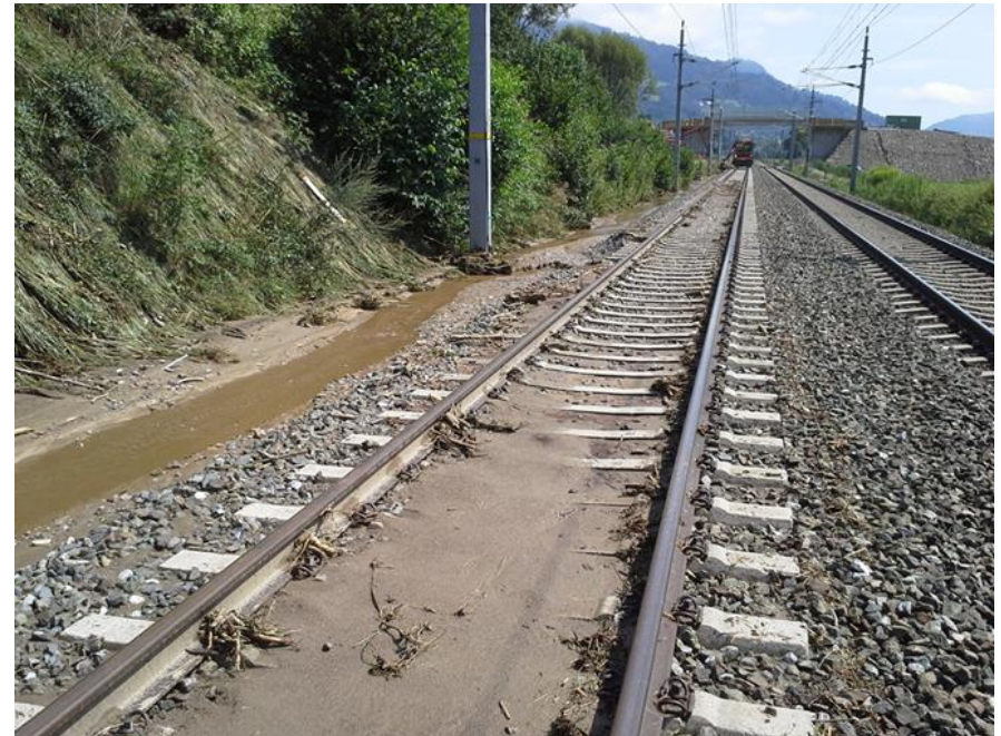
Schäden an der Südbahnstrecke durch Erosion (ÖBB)
