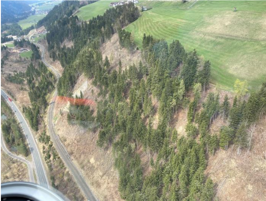
Schutzwald oberhalb der Bahnstrecke im Pustertal, 2022 (ÖBB)
