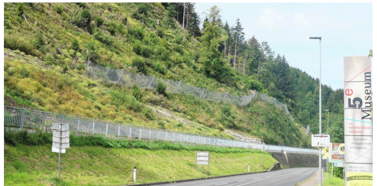
▲ Kürzlich wurde das Schutzwald-Projekt Sattelgraben in Kreilhof in Waidhofen fertiggestellt.
